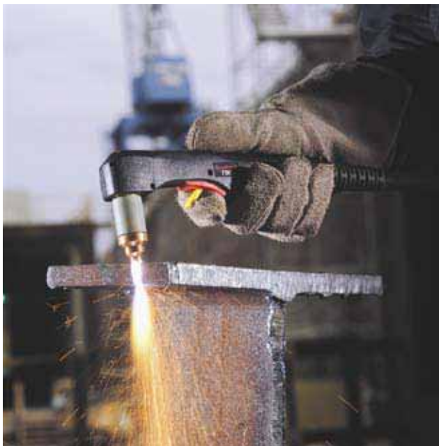
Figura 10 – Detalhe do Processo de Corte Manual
